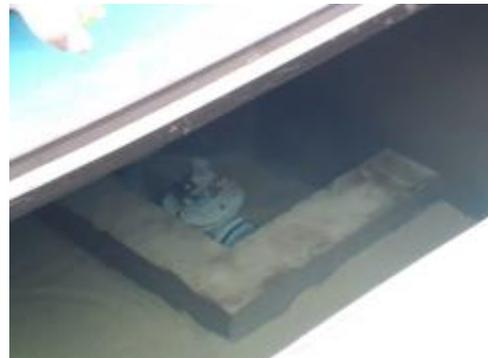
「③ろ過槽」が沈殿槽のまた下にあります。見た目よりずっと深くて、下に砂利、その上に砂が入っていて小さなゴミを取り除いてくれます。ゴミが溜まったら水を抜いて取り除くそうです。
